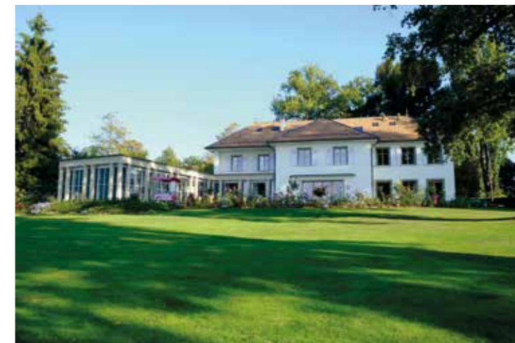
Villa du Nant d'Aisy en 2018 après les transformations initiées par le Conseil de Fondation
